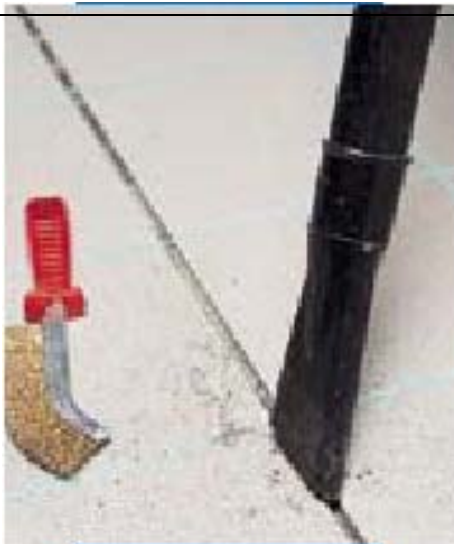
Очистка шва пылесосом
