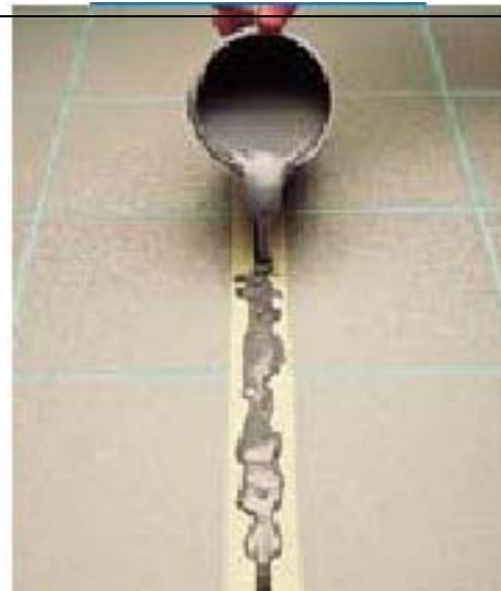
Заполнение шва Mapeflex PU21
