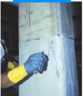
Нанесение шпаклевки МареWrap 11 или МареWrap 12
